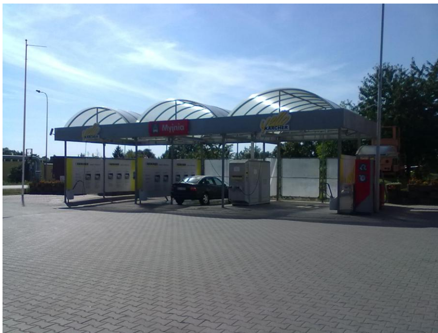
Ryc. 5 Trzystanowiskowa myjnia pojazdów – z prawej odkurzacz samochodowy i automatyczna sprężarka powietrz z lewej utwardzona powierzchnia nad separatorem
