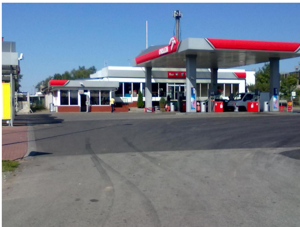
Ryc. 2 Widok ogólny stacji paliw i w pełni zmodernizowanej bezdotykowej myjni pojazdów samochodowych firmy KÄRCHER – po lewej stronie
