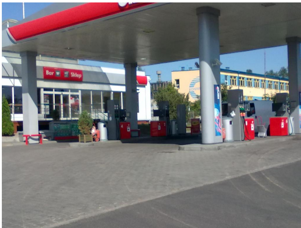
Ryc. 1 Widok na stację paliw po przeprowadzeniu modernizacji
